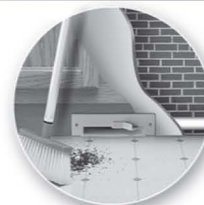
6 – пневмосовок с контактами низковольтной электрической цепи
